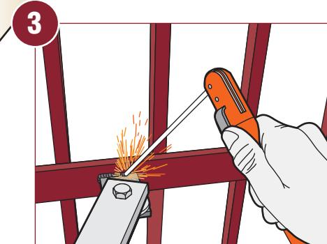
Verificar que el brazo esté nivelado y fijar la ménsula en esta posición con puntos de soldadura.
